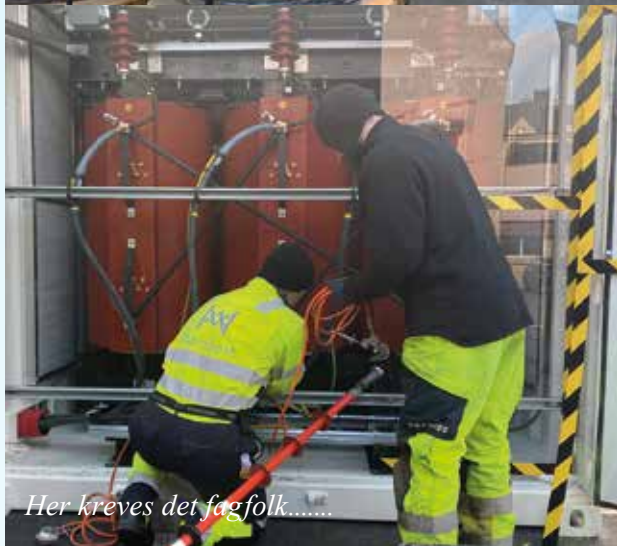
Mye kabler som må til.....
