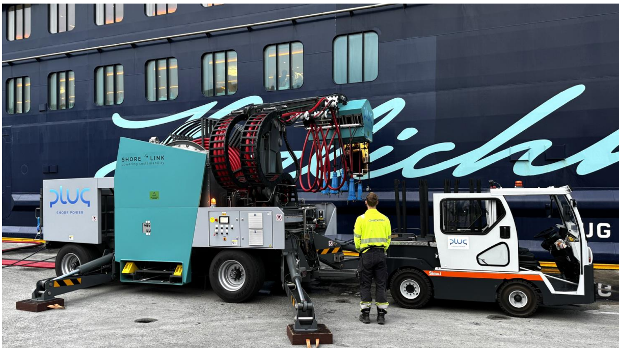
Nytt landstrømanlegg ved Sørsidekaiene i mai 2023.
