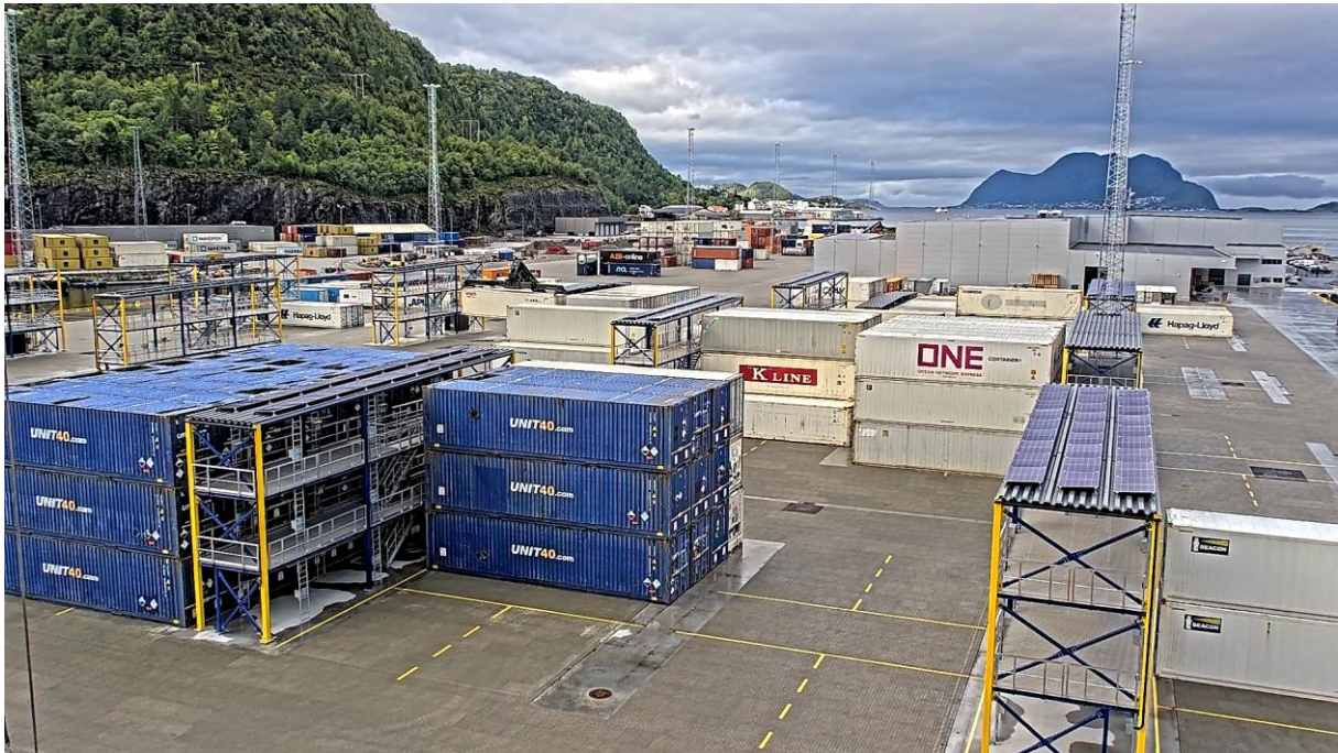
Allerede full fart på det nye terminalområdet – en måned etter åpning.
