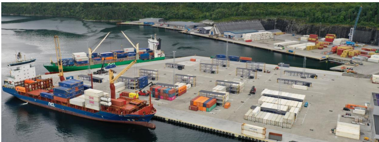
Deler av den nye containerterminalen fra 2024 på Flatholmen, med den opprinnelige området fra 2004 i bakgrunnen.
